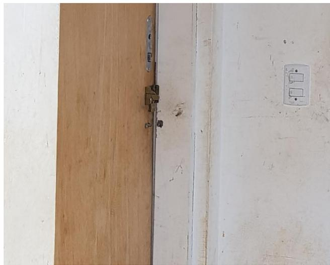
**Figura 13: Fechadura quebrada**
