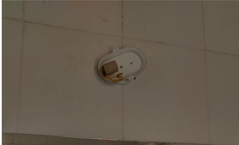
**Figura 22: Luminária deteriorada**
